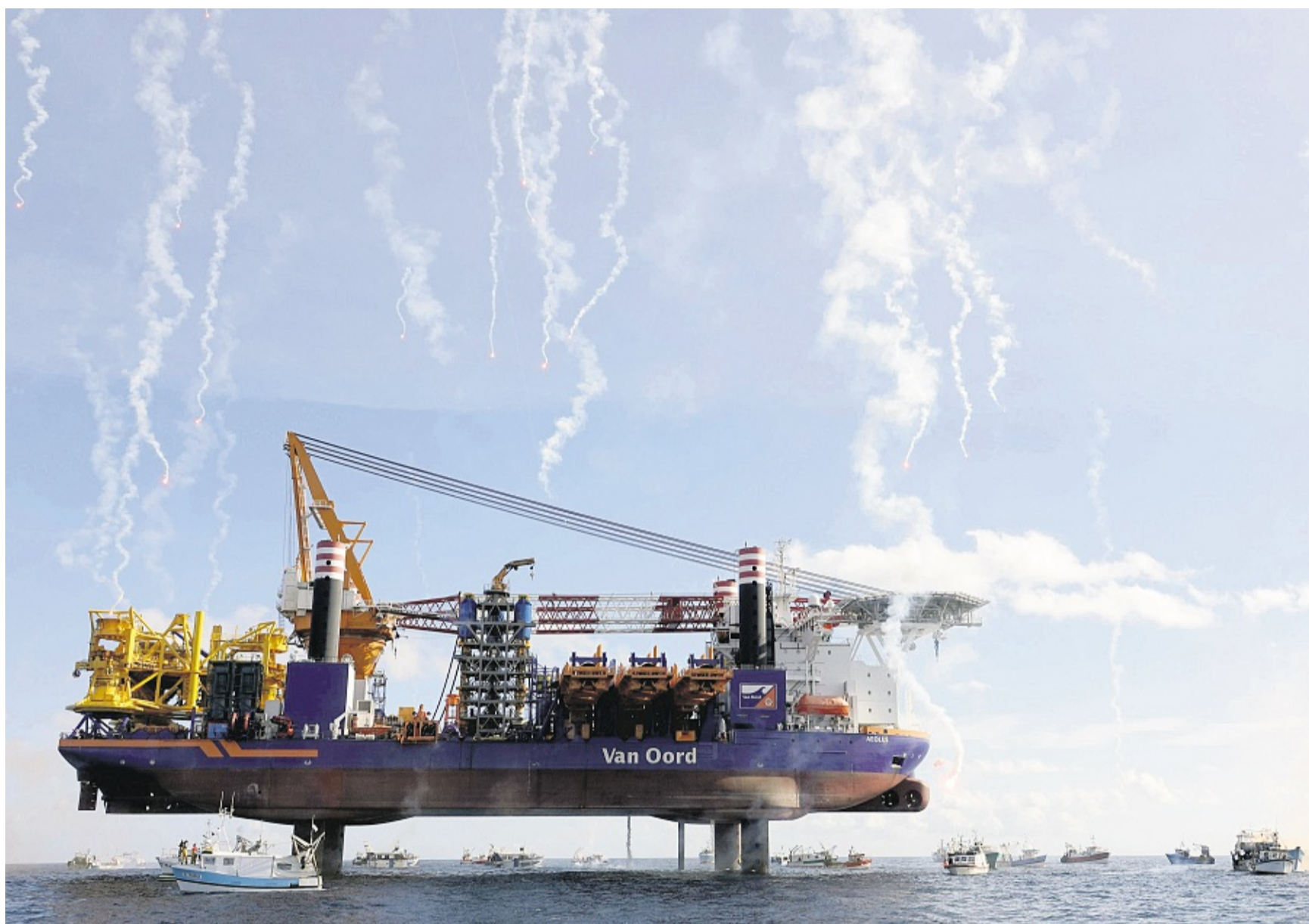
Rassemblement de bateaux de pêche pour protester contre le chantier, en baie de Saint-Brieuc (Côtes-d'Armor), le 7 mai. VINCENT MOUCHEL/PHOTOPQR/OUEST FRANCE/MAXPPP
