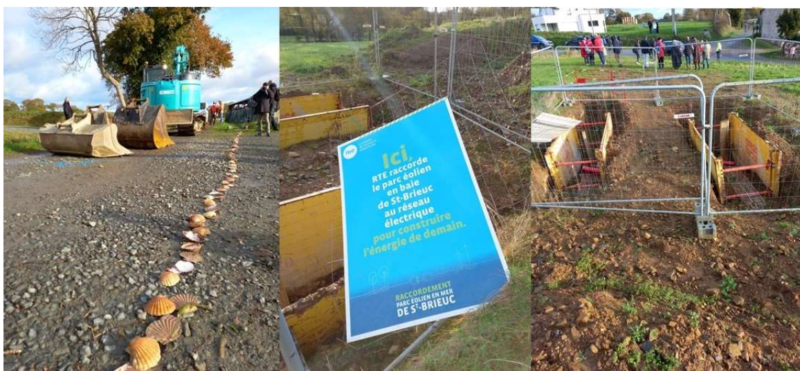
*Photos prises lundi, démarrage du chantier
