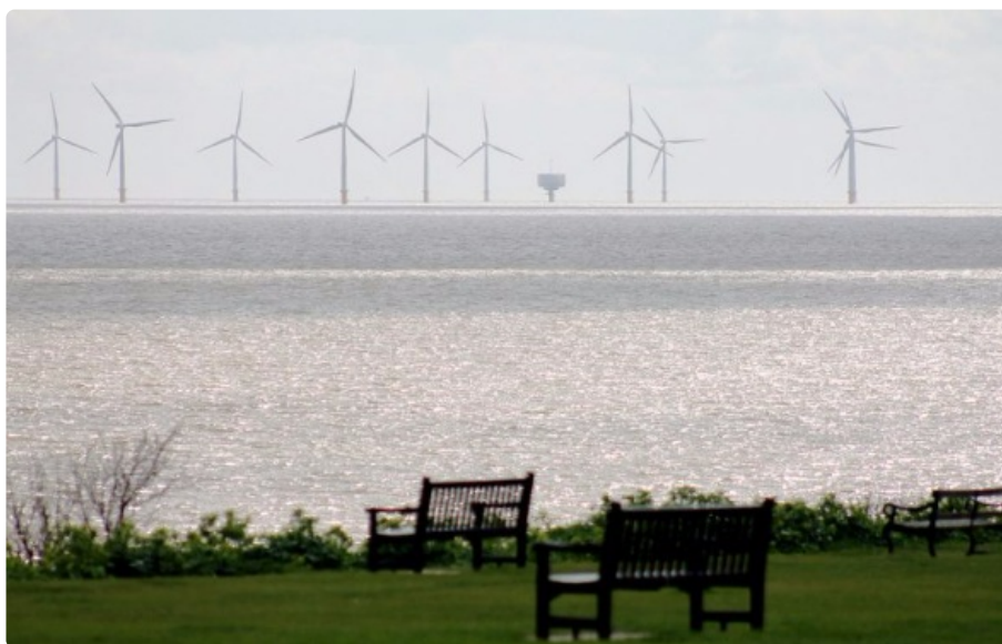
Eoliennes Siemens de Gunfleet Sands depuis Frinton-on-Sea, éoliennes de 128 mètres de haut (3,6 MW) à 7 km de la côte. Photo Colin Brooks©
